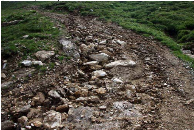
profonde incisioni ed erosioni lungo la pista di servizio
